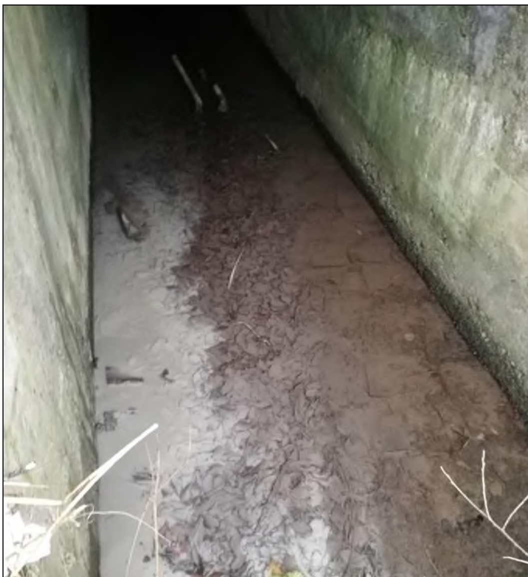
Obr. č. 4 - pohled na zanesené koryto propustku
